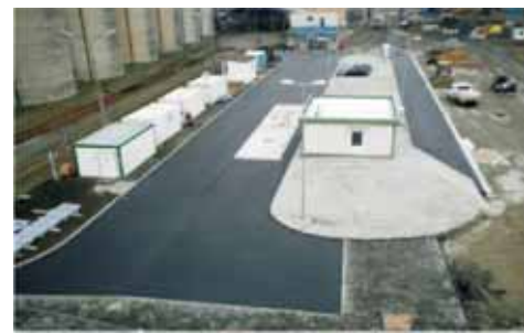
Celkový pohled na dokončení 1. fáze 8. 3. 2013
