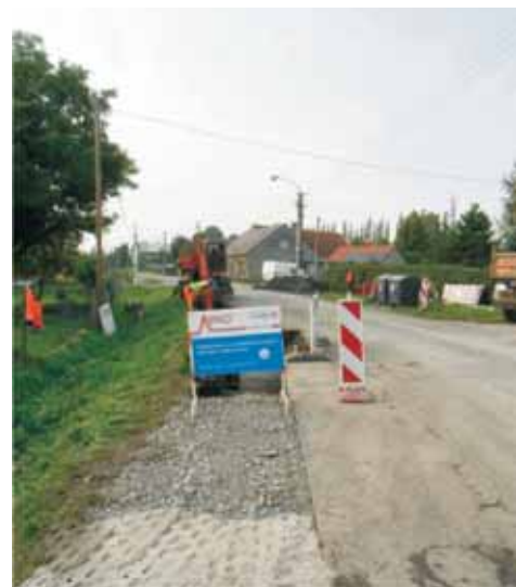
Realizace hlavní stokové sítě – stoka A2
