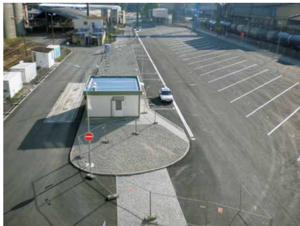
Kompletní dokončení díla 13. 5. 2013
