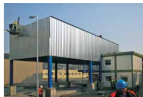
Montáž opláštění ocelové konstrukce přístřešku
