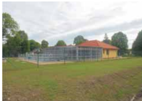
ČOV Bartošovice – před spuštěním do zkušebního provozu
