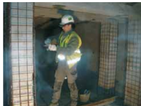
EPRU 502 Strojovna - betonky
